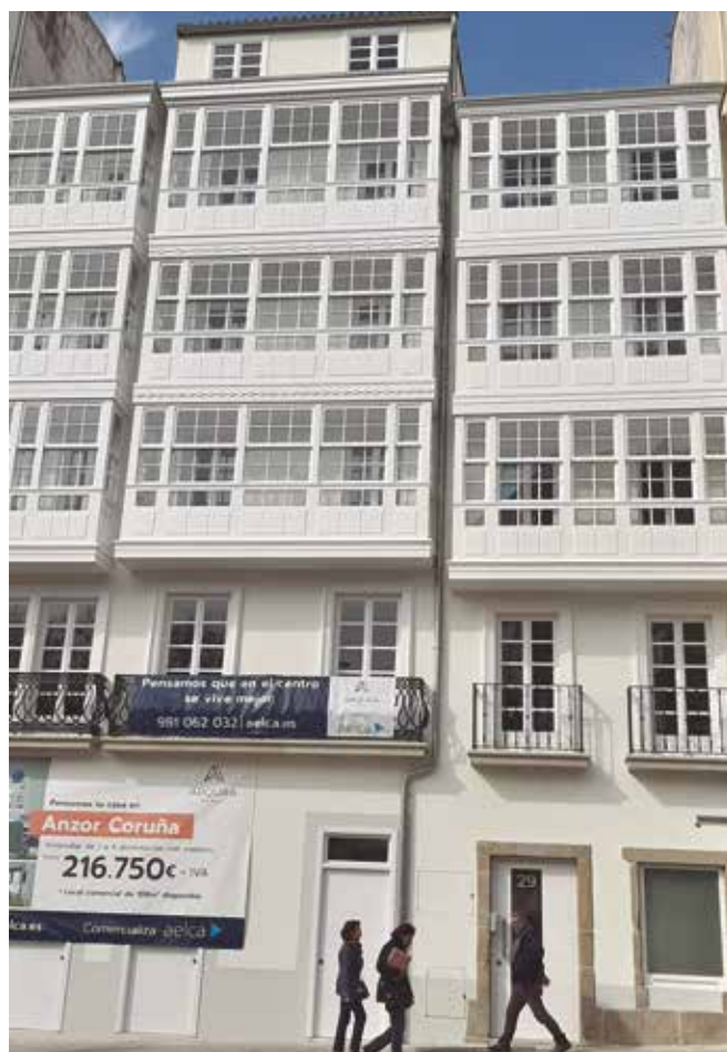
Foto: Fachada de un edificio promovido por Árqura Homes en A Coruña (Galicia).
