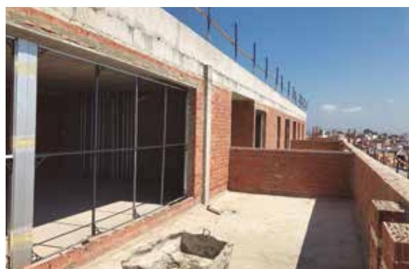
Foto: Edificio de Árquira Homes en construcción en Torrent (Comunidad Valenciana).
