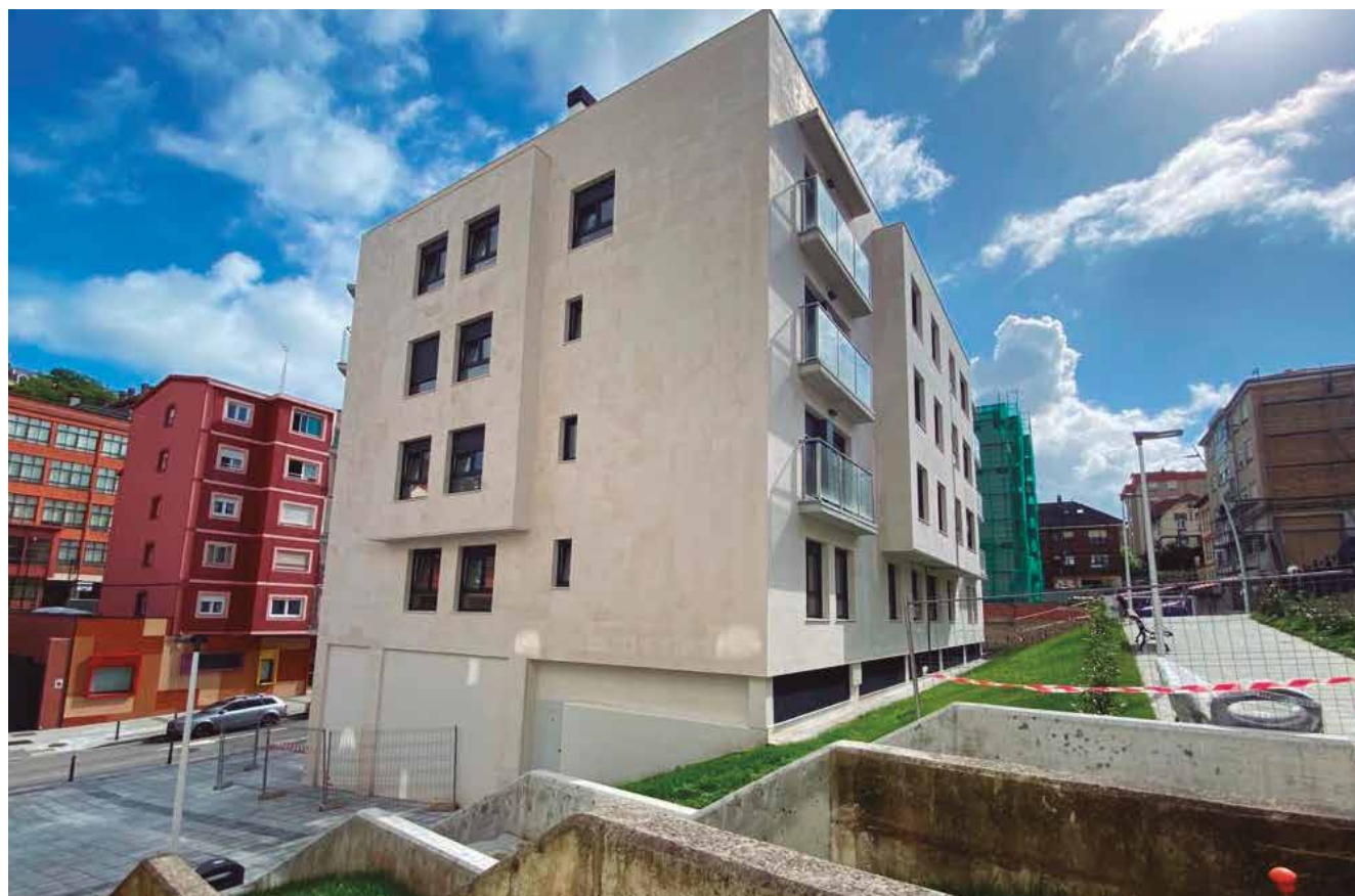
Foto: Edificio de Árkura Homes en construcción en Santander (Cantabria).
